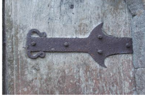
Ek 9. Civelekođlu konađında Kurt başının sembolize edildiđi kapı menteşesi, Yaltkaya köyü, Hemşin (Hiçyılmaz, n.d.).
