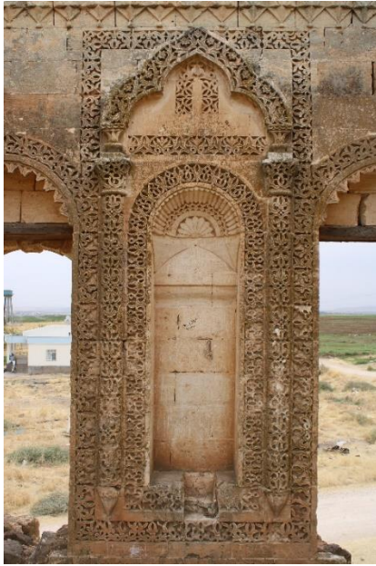
Foto. 8. Güney Duvarda Yer Alan Niş
