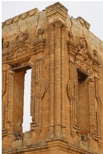
Foto. 5. Köşeleri Sınırlayan Üçlü Demet Sütünceler ve Konsollar
