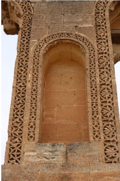
Foto. 16. Kuzey Duvarda Yer Alan Niş
