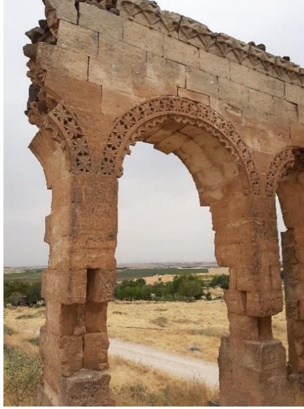
Foto. 10. Doğu Duvarı Genel
