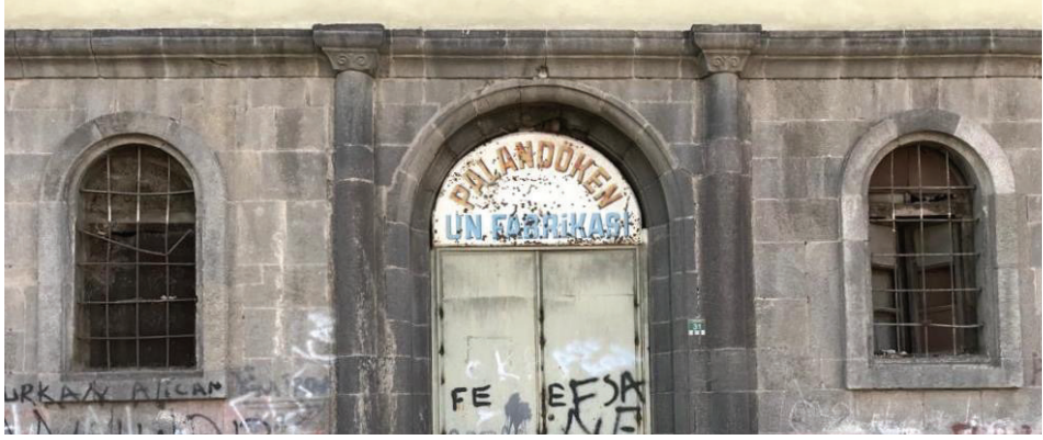
G. 6: Koç boynuzu kabartma başlıklı plasterler ve kesme taşlı kemerli pencereler (Z. Gürbüz, 2022)
