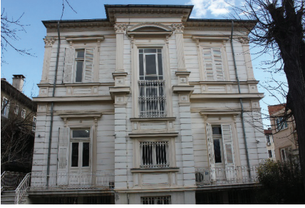
G. 4: Batı cephe (M. Dündar, 2020)
