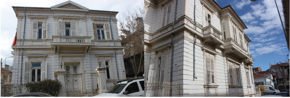
G. 2: Doğu cephe (M. Dündar, 2020)
