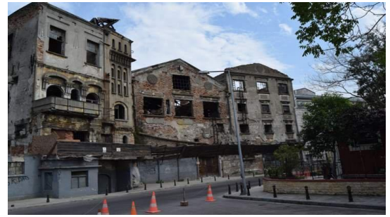
Şekil 11. Kasımpaşa Un Fabrikası yapılarının kuzey cephesi, 2017 (Url-5)
