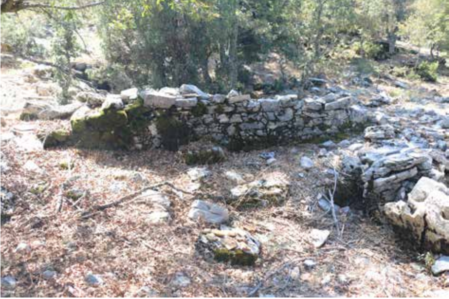
Fig.14 Üçkuyular Konut Duvarları
