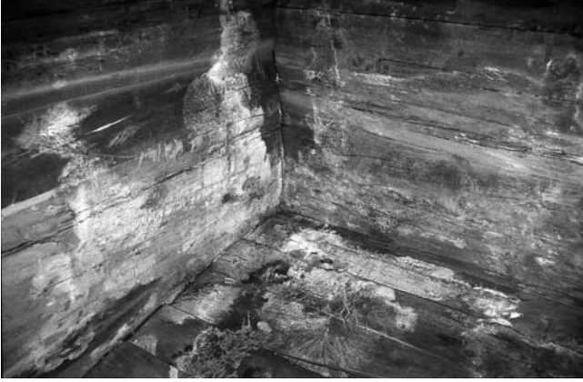
Res.8 Polatlı, Midas Tümülüsü mezar odası ahşaplarında mantar saldırısı
