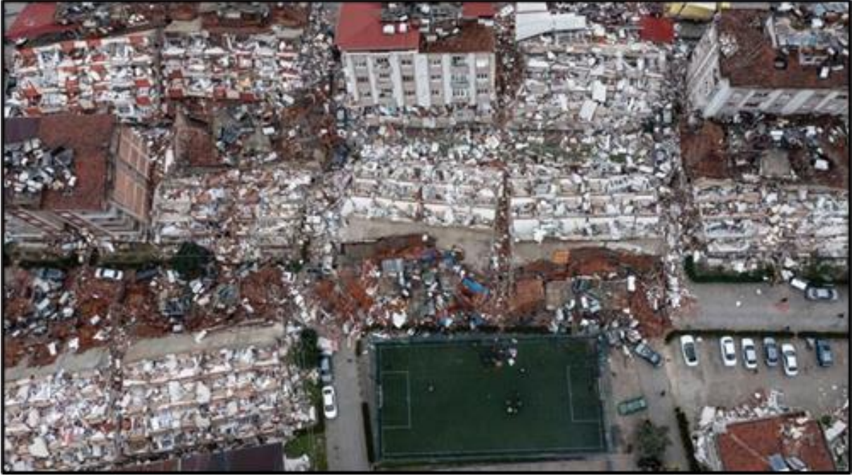
Şekil 2. Kahramanmaraş ve Gaziantep depremleri sonrası meydana gelen hasarlar (2023 yılı) (1) (URL 1).
