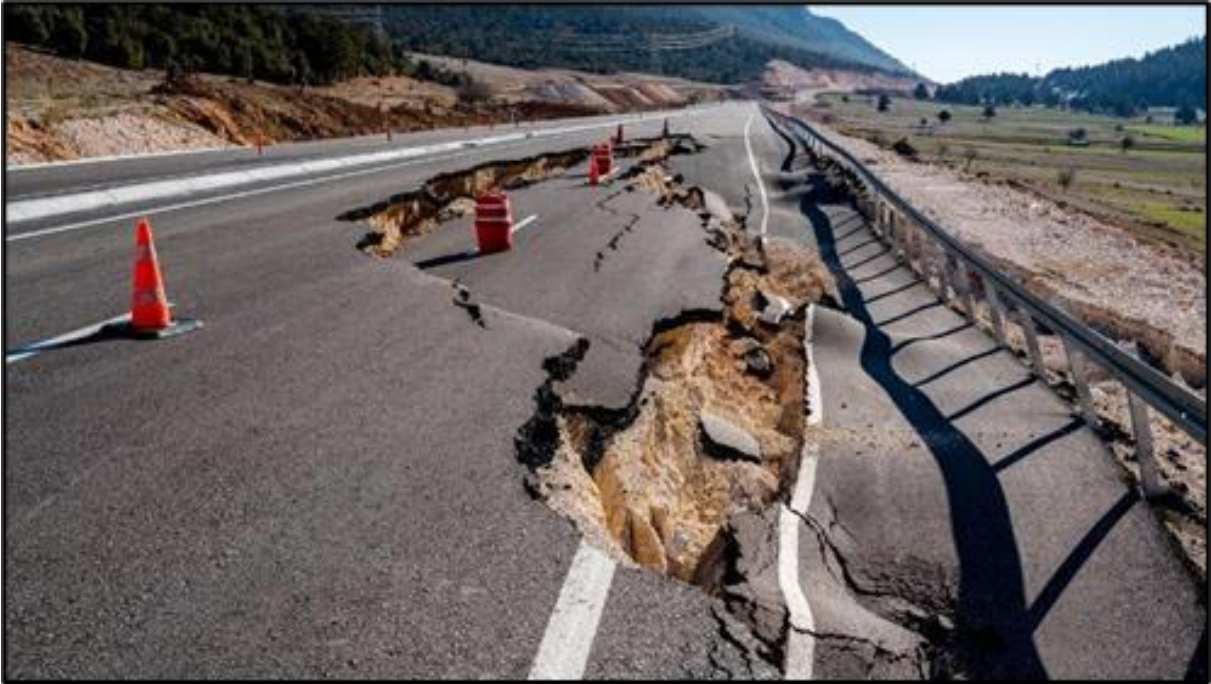
Şekil 3. Kahramanmaraş ve Gaziantep depremleri sonrası meydana gelen hasarlar (2023 yılı) (2) (URL 1).
