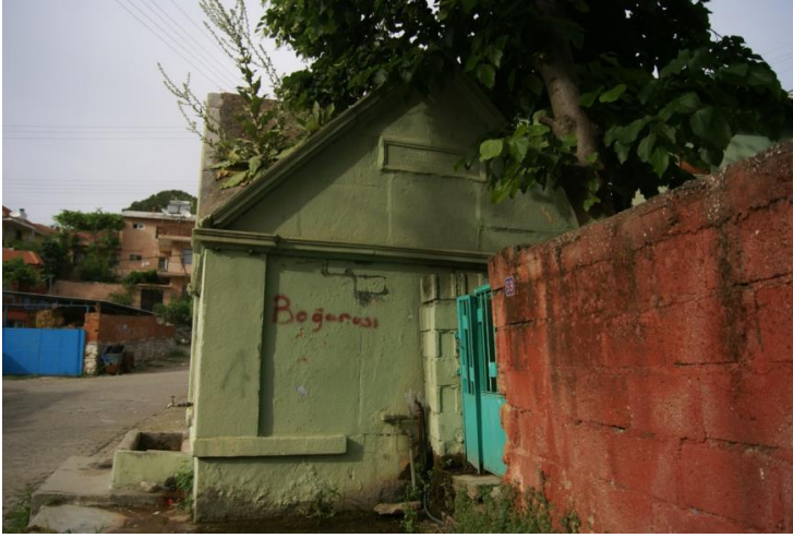
Foto 6: Bağarası Camikebir Çeşmesi Güney Cephe
