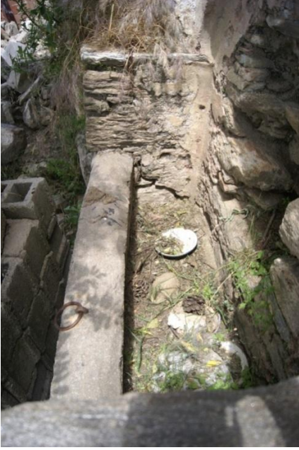
Foto 18: Bağarası Akçakaya Köyü Çeşmesi Yalak Kısım
