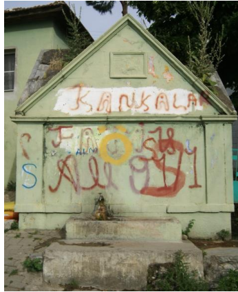
Foto 2: Bağarası Camikebir Çeşmesi Batı Cephe
