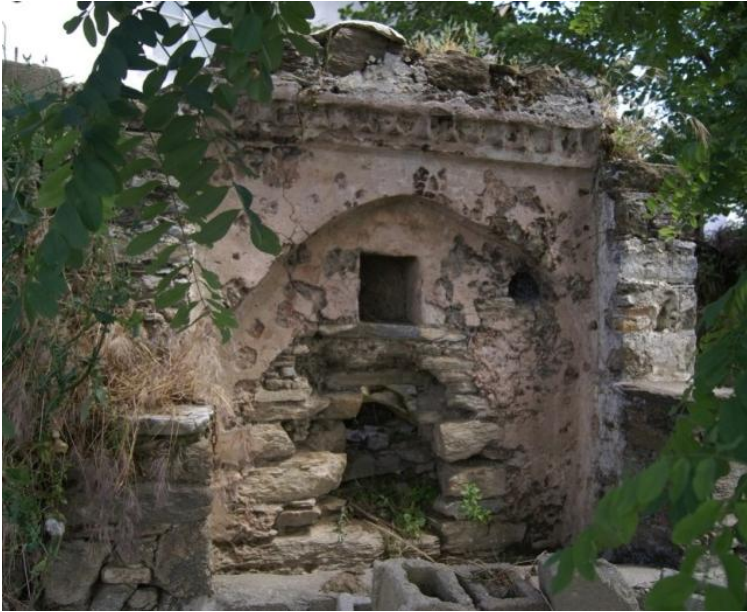
Foto 17: Bağarası Akçakaya Köyü Çeşmesi Ana Cephe ve Saçak Kısmı
