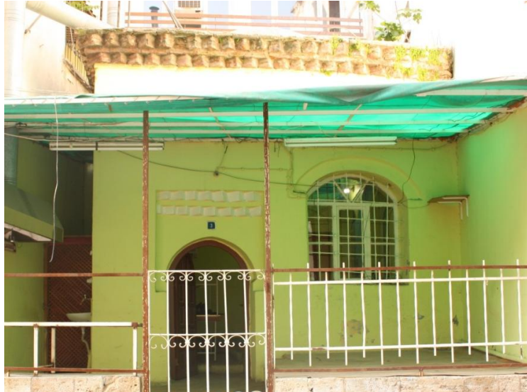
Foto 29: Aydın Abdullah Paşa Sebili Testere Dişi Uygulamaları
