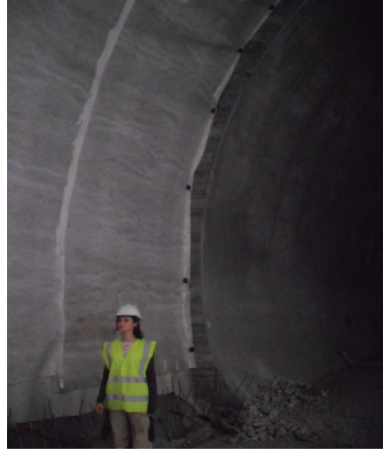
b) 33-34 nolu tünellerin kesişme noktası (33 nolu tünelde kaplama beton imalatı bitmiştir)
