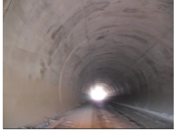
d) Kaplama beton imalatı tamamlanan 31 nolu tünel
