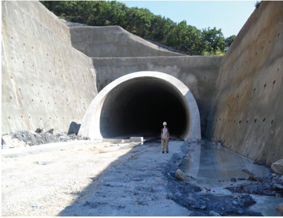
e) Kaplama beton imalatı tamamlanan 32 nolu tünelin giriş kısmından görünüşü.
