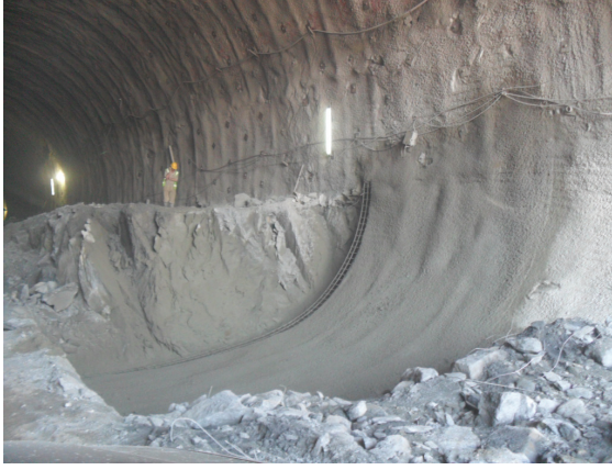
c) 35 nolu tünel de invert imalatı ve invert-üstüarı arasındaki deformasyon
