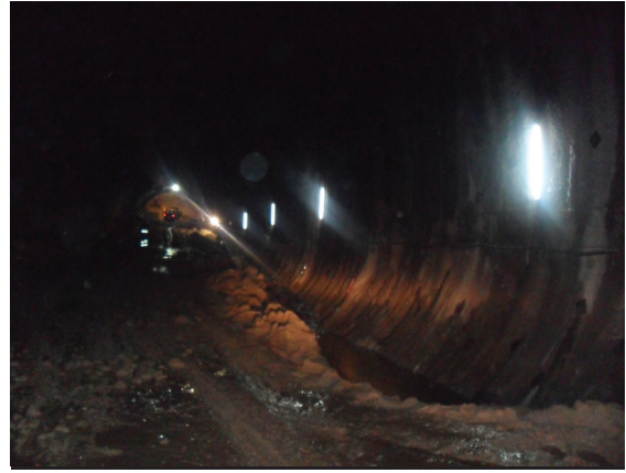
f) 36 nolu tünelde birincil destek sistemi imalatı tamamlanmış kısım
