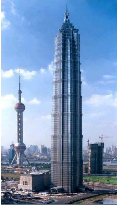
Şekil 12. Jin Mao Binası görünüşü (Tasarım: Adrian Smith- Skidmore, Owings and Merrill, 1999, Şanghay-Çin) (Choi, Ho, Joseph, & Mathias, 2012, s. 60).
