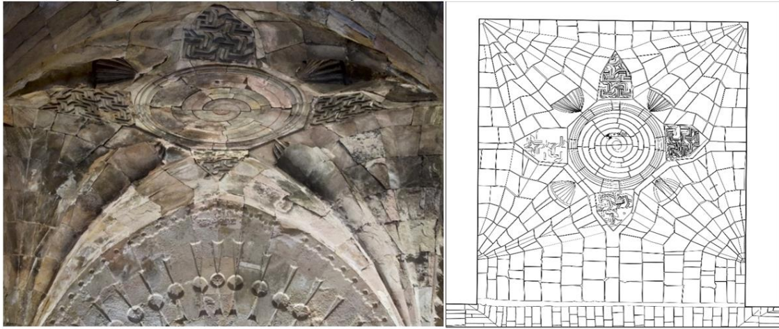
Şekil 6: Divriği Şifahanesi'nin altı kenarlı tonozu (Sevda Atak) ve planı (Ankara Vakıflar Genel Müdürlüğü Arşivi, 1999).
