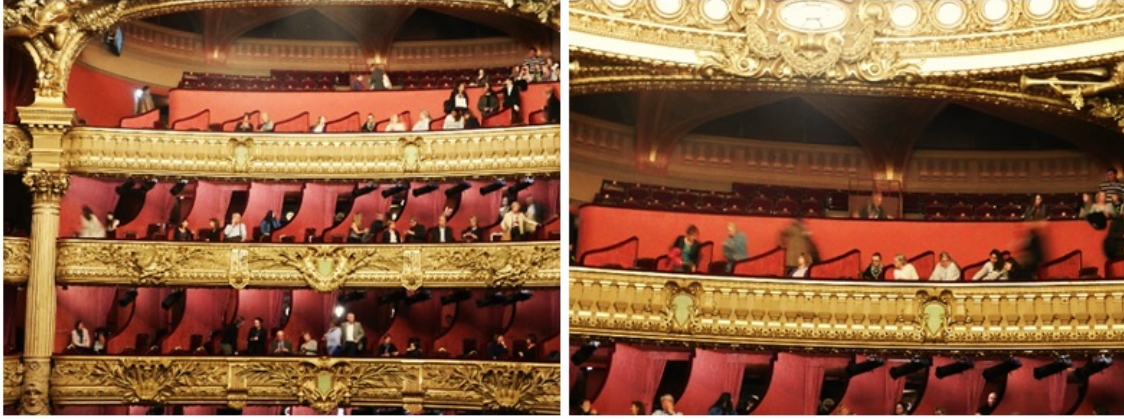
Şekil 24. Balkon parapet duvar yüzeylerindeki süslemeler (M. Kavraz Arşivi)
