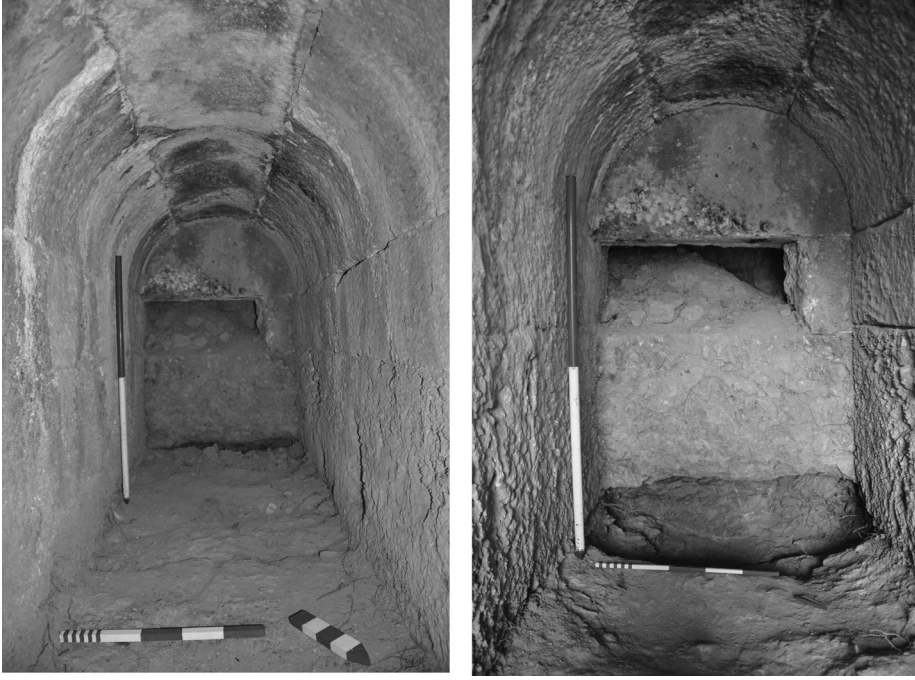
Fig. 7 Dromosun tonozlu üst örtüye sahip iç kısmı ve Dromos sonundaki duvar.
