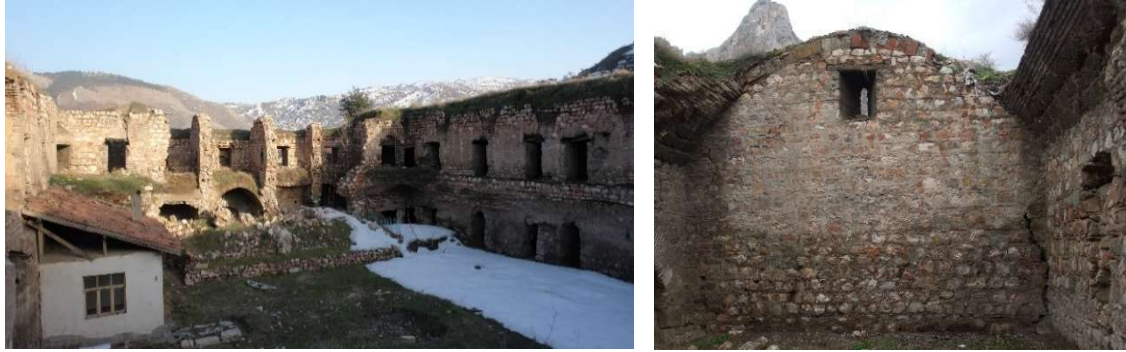
Şekil 1. Deveci Hanının 2007 yılı avlu ve develik bölümü görünüşü (Tokat Vakıflar Bölge Müdürlüğü Arşivi).
