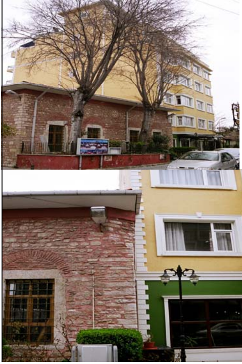
Şekil 8. Kültür varlığına yapı yaklaşma mesafesinin aşıldığı uygulamalar.
