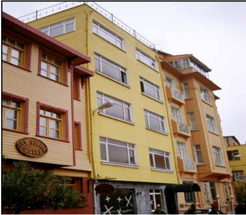
Şekil 9. Yapı yapma yasağı kararına aykırı yapılar.
