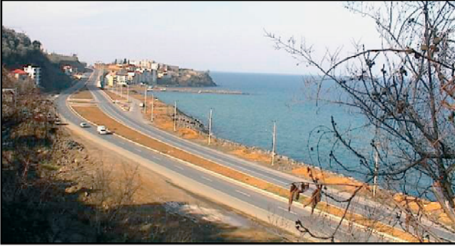
Şekil 6. Bölünmüş yola dönüştürülmüş karayolu (Trabzon Akçakale)
