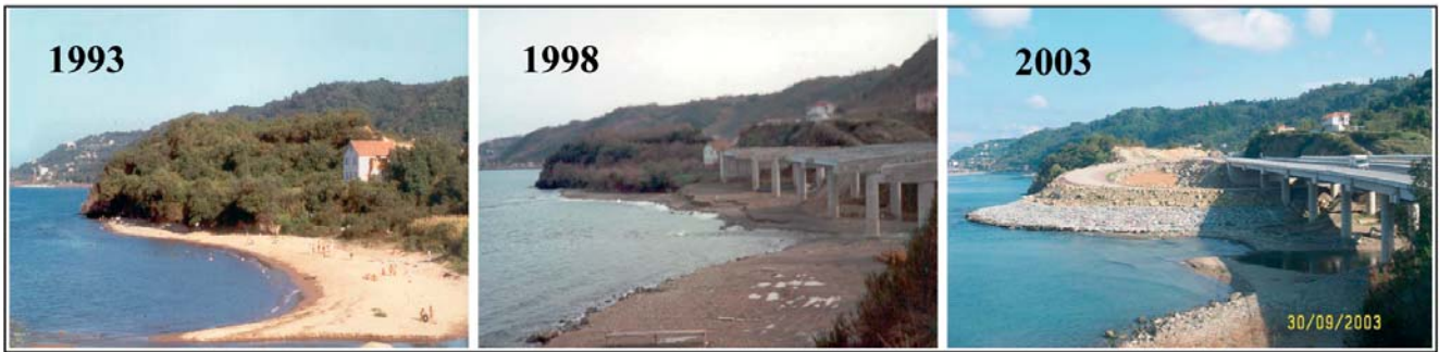
Şekil 10. Yanbolu köyünde aynı yere ait karayolu inşaatından önceki ve sonraki durumu gösteren fotoğraflar
