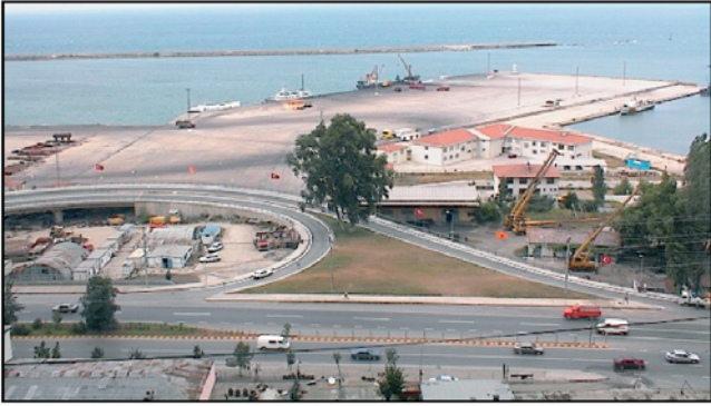
Şekil 7. Arafilboyu mevki dolgu yapılarak genişletilmiş liman sahası
