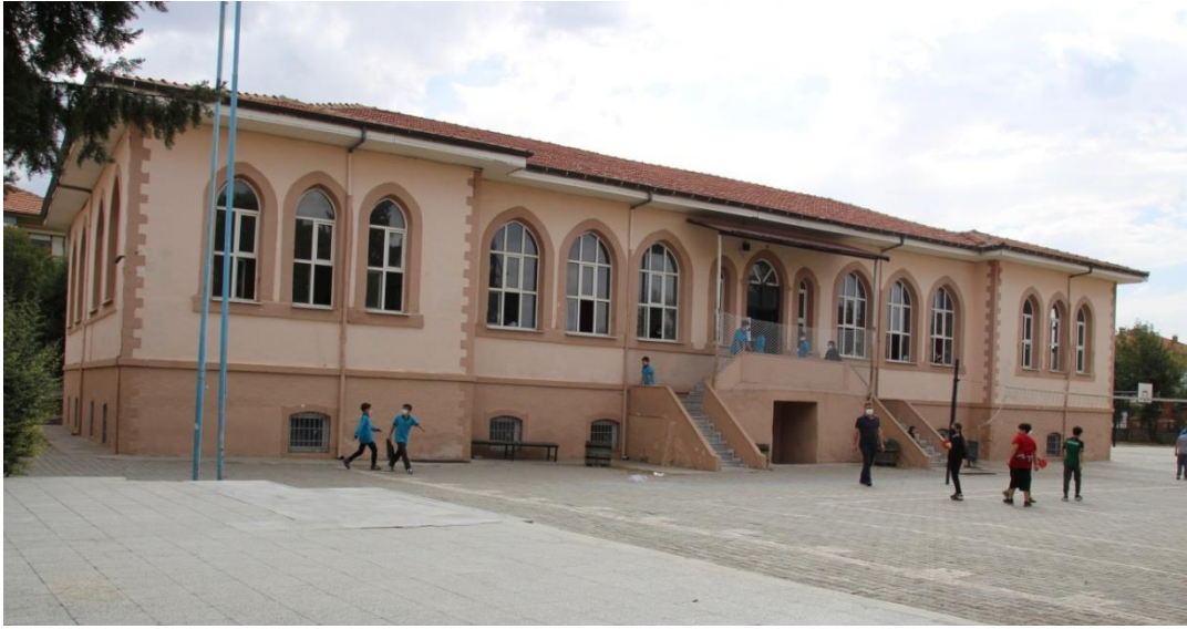
Fotoğraf 11. Çivril Çatlar İlkokulu, Geniş Bahçeye Bakan Arka Cephe (Meryem Yıldız, 2021)
