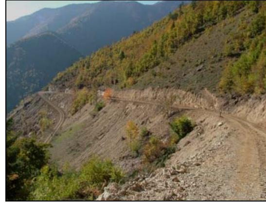
Şekil 1. 126 kod nolu yoldan bir görünüm
