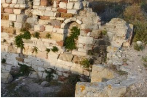
Şekil 39. Kuzey duvarındaki kemerli niş (2014)
