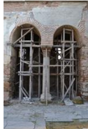
Şekil 6. Naos ile köşe odaları ayıran kemerler (2014)
