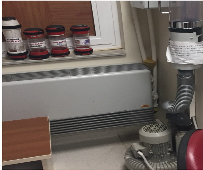
Şekil 3: Pnömatik Taşıma Sistemi Kompresör ve Taşıyıcılar (Pneumatic Conveying System Compressor and Carriers)
